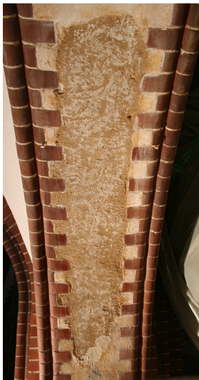
Ansichten einer Emporenbogenlaibung während der Bearbeitung
