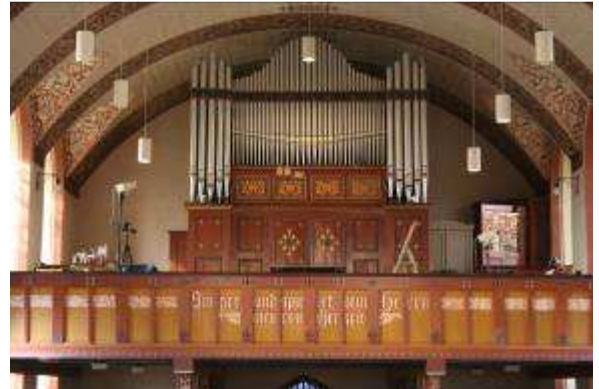
Gesamtansicht der Orgelempore
