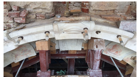
Injektage + Verpressung Marmorverkleidung
