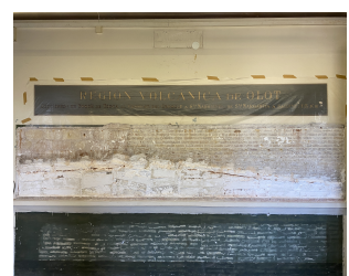
Endzustand, nach Demontage
