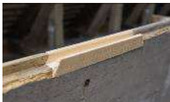
Bearbeitungsschritte bei der Restaurierung der Bohlen
