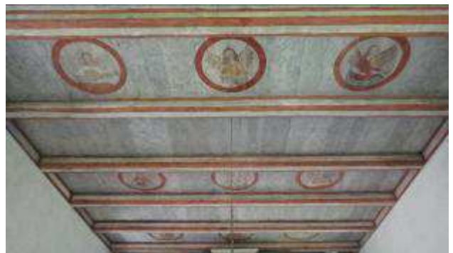
Vor- und Endzustandsansicht der barocken Bohlendecke
