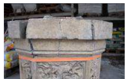
Restaurierung des Terrakottasockels
