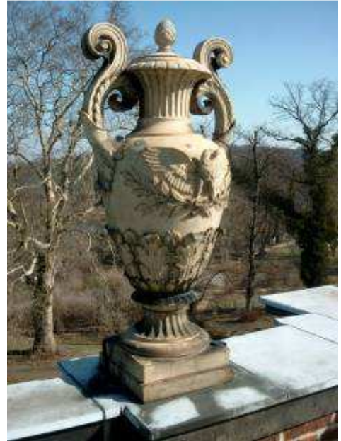
Attikavase auf der Orangerie vor der Restaurierung
