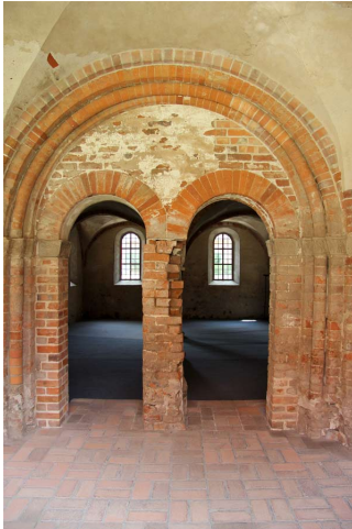
Detailansicht östlicher Kreuzgang
