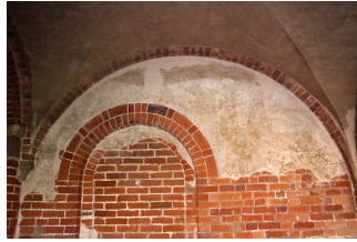
Endzustand eines konservierten Putzfeldes
