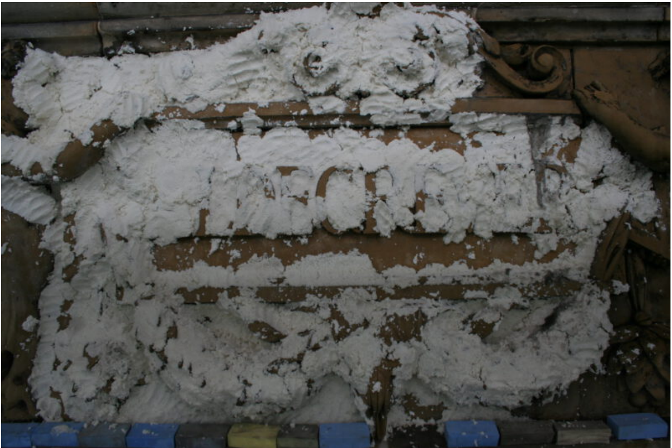
Kompressenreinigung zur Abnahme von aufliegenden Krusten
