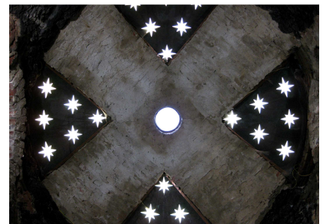
Endzustand der restaurierten Innenraumgrottierung mit reapiplizierten Zinkblechtafeln und vergoldeten Sternen in der Kuppel
