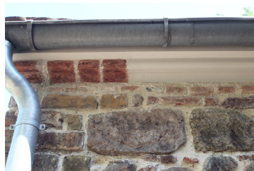
Endzustand Stuckgesims
