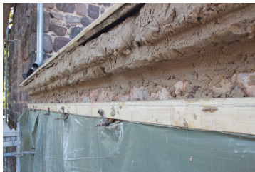
Detail Rekonstruktion Stuckgesims
