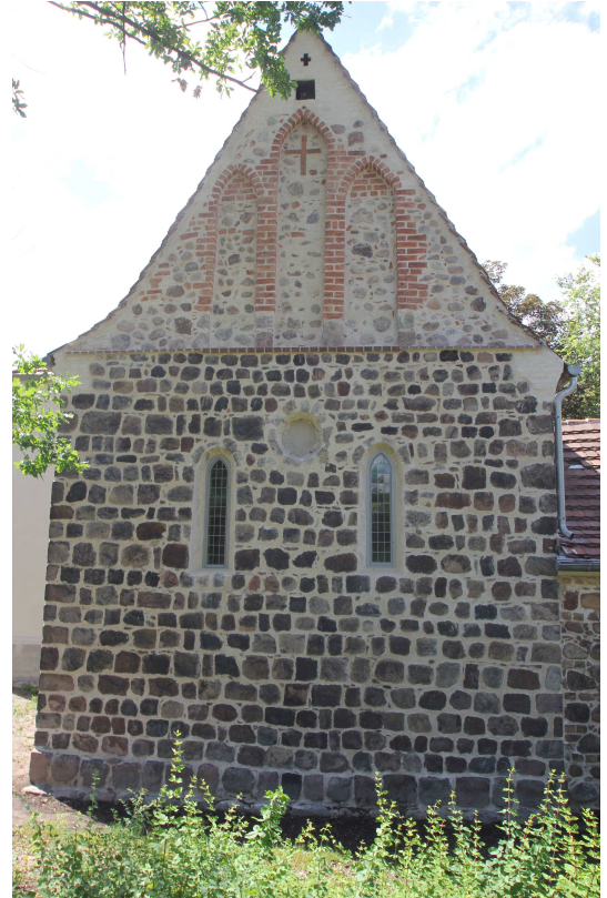
Ansicht des Ostgiebels im Endzustand
