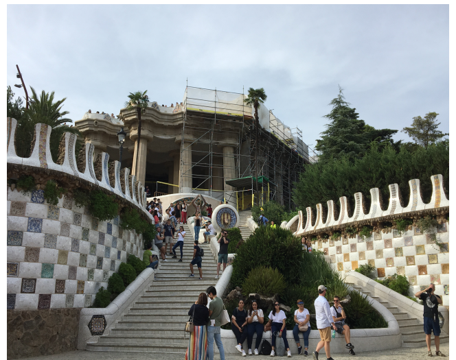
Eingang zum Parc Güell mit der Baustellensituation
