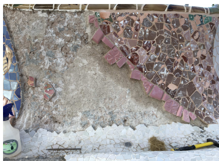
Demontage des geschädigten Mosaikfeldes
