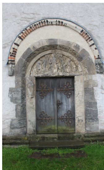
Ansicht Nordportal im Endzustand
