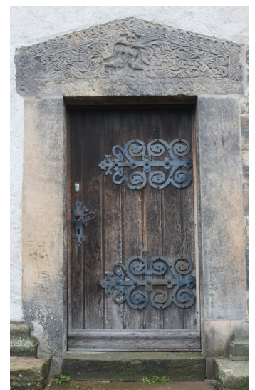
Ansicht Nordportal im Endzustand
