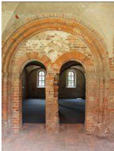
Detailansicht östlicher Kreuzgang
