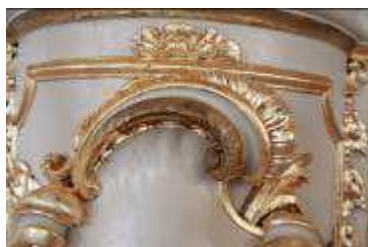
Restaurierung einer Rocaille
