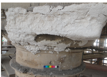
Detail Entsalzungskompreße
