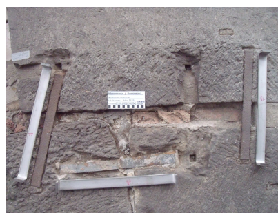
Detail Austausch von Klammern
