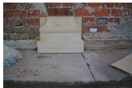
Detail Neuanfertigung Pilasterbasis
