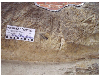
Detail Verklebung, Verdübelung
