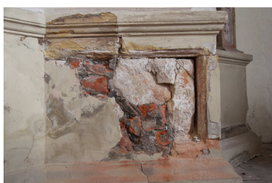
Probefreilegung eines Sockelfelds
