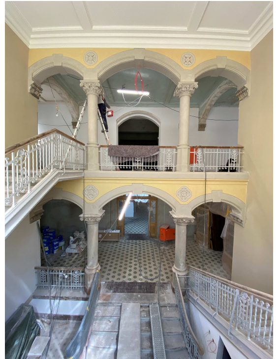
Ansicht des restaurierten Haupttreppenhauses
