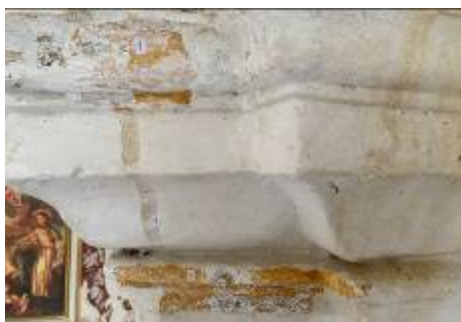
Befunduntersuchungen zur Fassungsabfolge vor Ort
