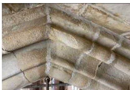
Bearbeitung von Werksteinfugen an einem Gurtbogen im südlichen Seitenschiff
