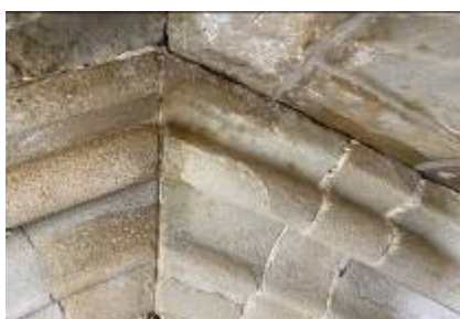
Bearbeitung von Werksteinfugen an einem Gurtbogen im südlichen Seitenschiff
