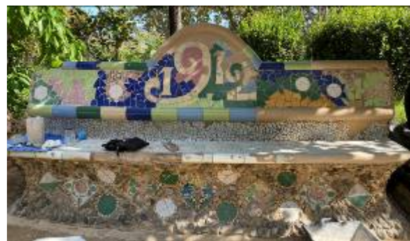
Ansicht einer Bank während der Restaurierung
