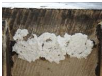
Mineralische Antragungen, Kompressenreinigung und Austausch einer Vierung am Naturstein
