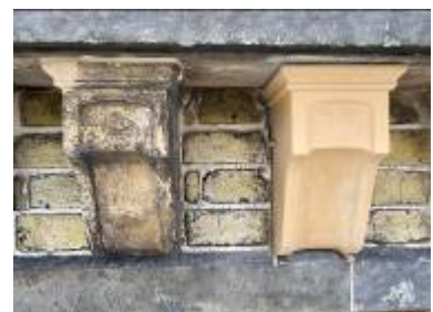
Abformung eines Kapitells, Rissinjektage und Montage von Nachbrandstücken an den Terrakottaelementen der Turmfassaden
