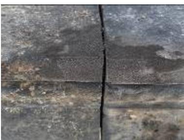
Mineralische Antragungen, Kompressenreinigung und Austausch einer Vierung am Naturstein
