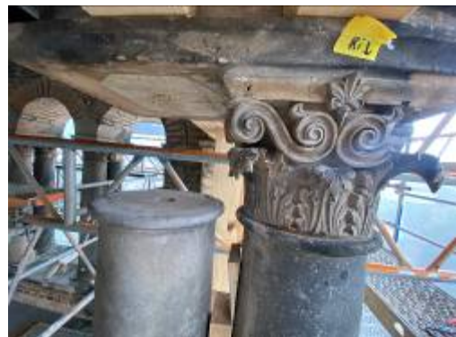
Austausch eines Terrakottakapitells (BMP)
