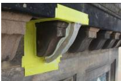
Abformung eines Kapitells, Rissinjektage und Montage von Nachbrandstücken an den Terrakottaelementen der Turmfassaden
