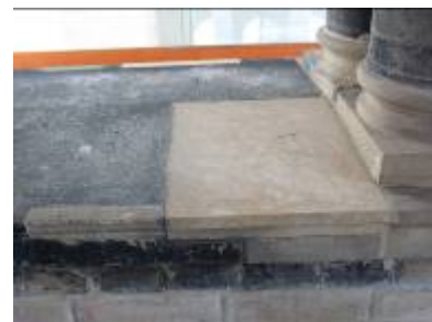
Mineralische Antragungen, Kompressenreinigung und Austausch einer Vierung am Naturstein
