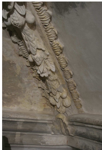
Detailansicht einer Stuckrahmung des Deckenspiegels während der Stuckrestaurierung und der Ausführung einer Neufassung
