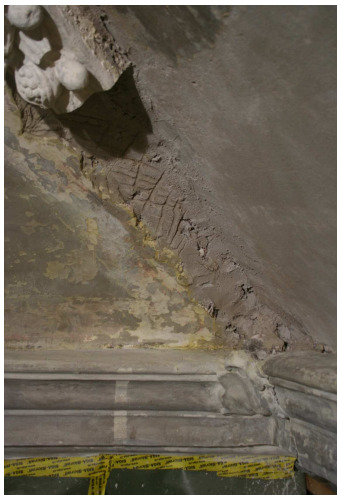
Detailansicht einer Stuckrahmung des Deckenspiegels während der Stuckrestaurierung und der Ausführung einer Neufassung
