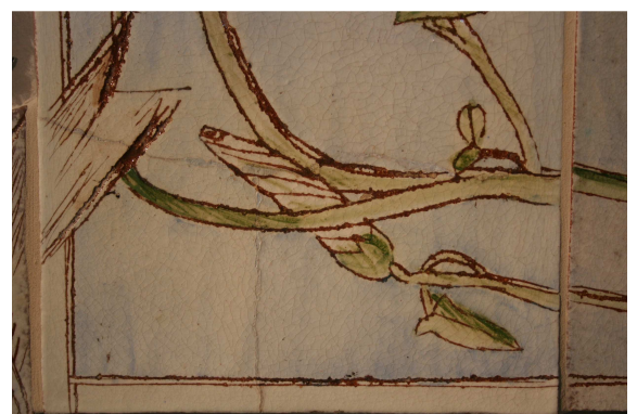
Detailansicht einer Wandbildfliese nach der Glasretusche
