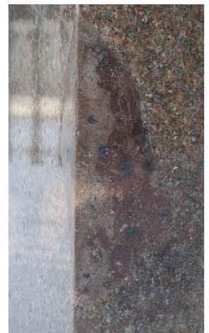
Unfallbedingte Schadensstelle an der Nordostecke des Denkmalsockels im Vor- und Endzustand sowie verschiedenen Bearbeitungszuständen
