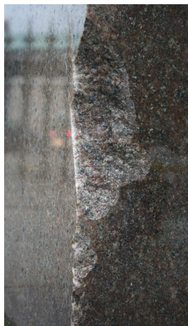
Unfallbedingte Schadensstelle an der Nordostecke des Denkmalsockels im Vor- und Endzustand sowie verschiedenen Bearbeitungszuständen
