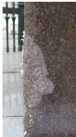
Unfallbedingte Schadensstelle an der Nordostecke des Denkmalsockels im Vor- und Endzustand sowie verschiedenen Bearbeitungszuständen
