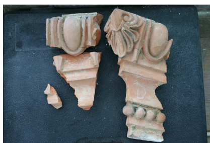
Schadensbereich an einer Ecke des Terrakottafrieses im Vorzustand, während der Klebung von Bruchstücken sowie im restaurierten Endzustand
