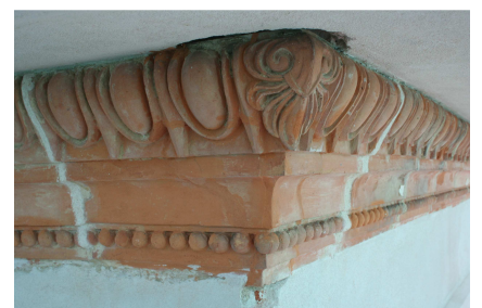
Schadensbereich an einer Ecke des Terrakottafrieses im Vorzustand, während der Klebung von Bruchstücken sowie im restaurierten Endzustand
