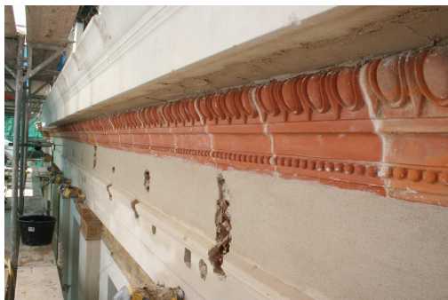
Terrakottafries vor und nach dem Versetzen der restaurierten Ornamentplatten und Nachbrandstücken
