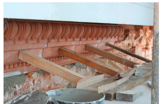
Versetzen von Nachbrandstücken am Terrakottafries
