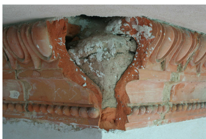
Schadensbereich an einer Ecke des Terrakottafrieses im Vorzustand, während der Klebung von Bruchstücken sowie im restaurierten Endzustand
