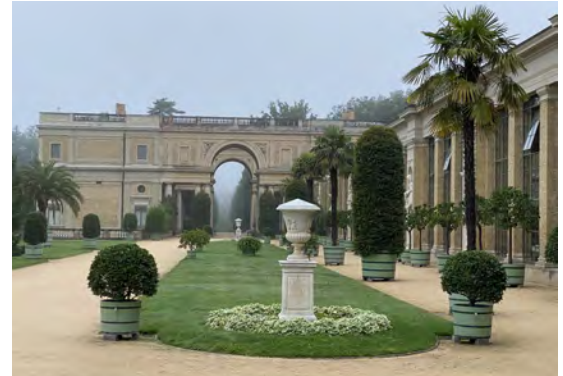
Ansicht Orangerieschloss Richtung Westen
